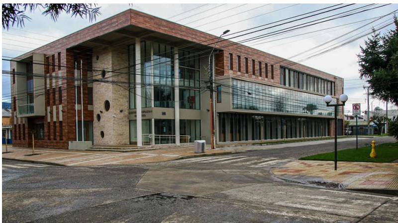
Edificio Consistorial de Gorbea
