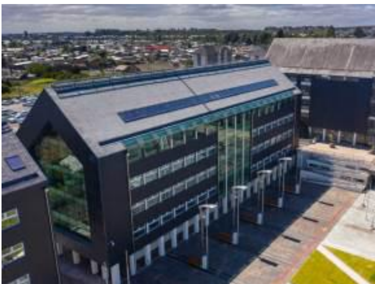
Edificio sector Justicia de Puerto Montt
