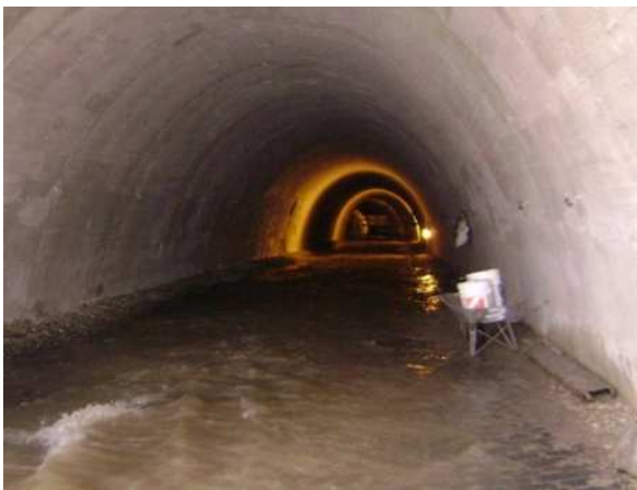
REPARACIÓN BÓVEDA ZANJÓN DE LA AGUADA RM
