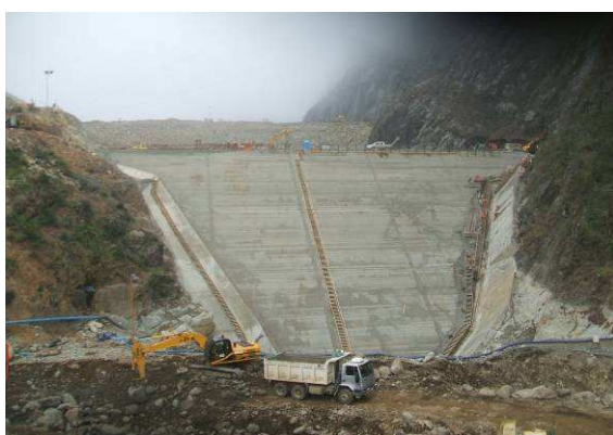
CONSTRUCCIÓN EMBALSE ANCOA,
