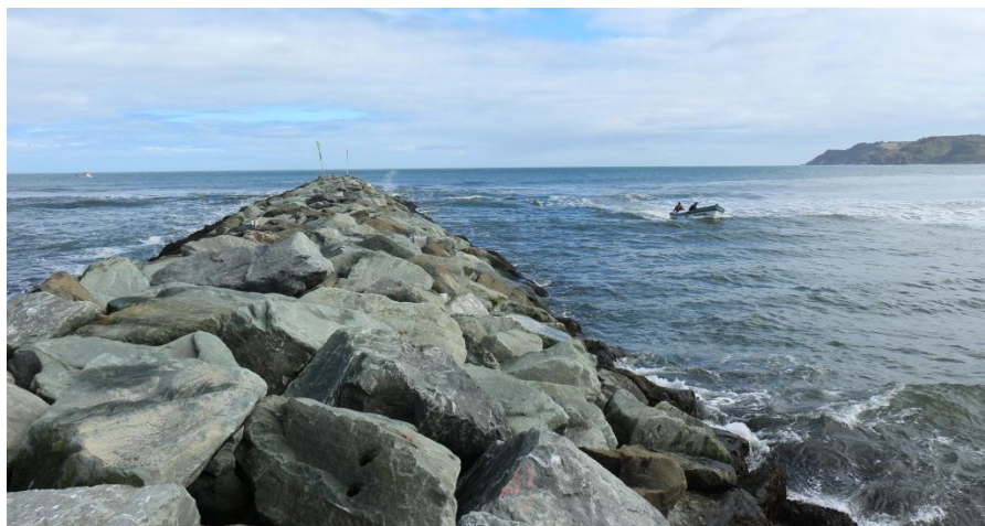
Reparación Espigones en Río Tirúa
