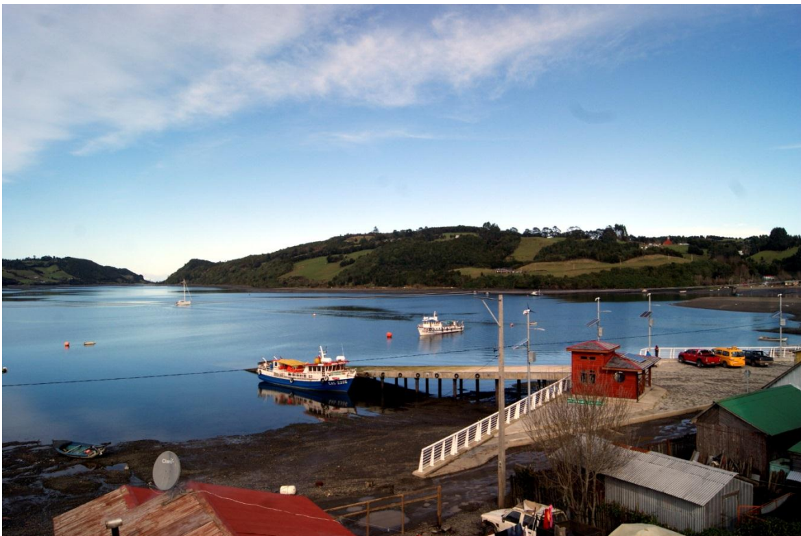
Reposición de Rampa de Isla Quehui, Castro
