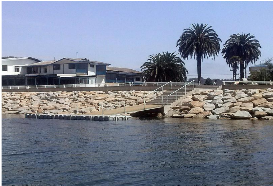
Mejoramiento del Borde Costero de Constitución Sector Fluvial
