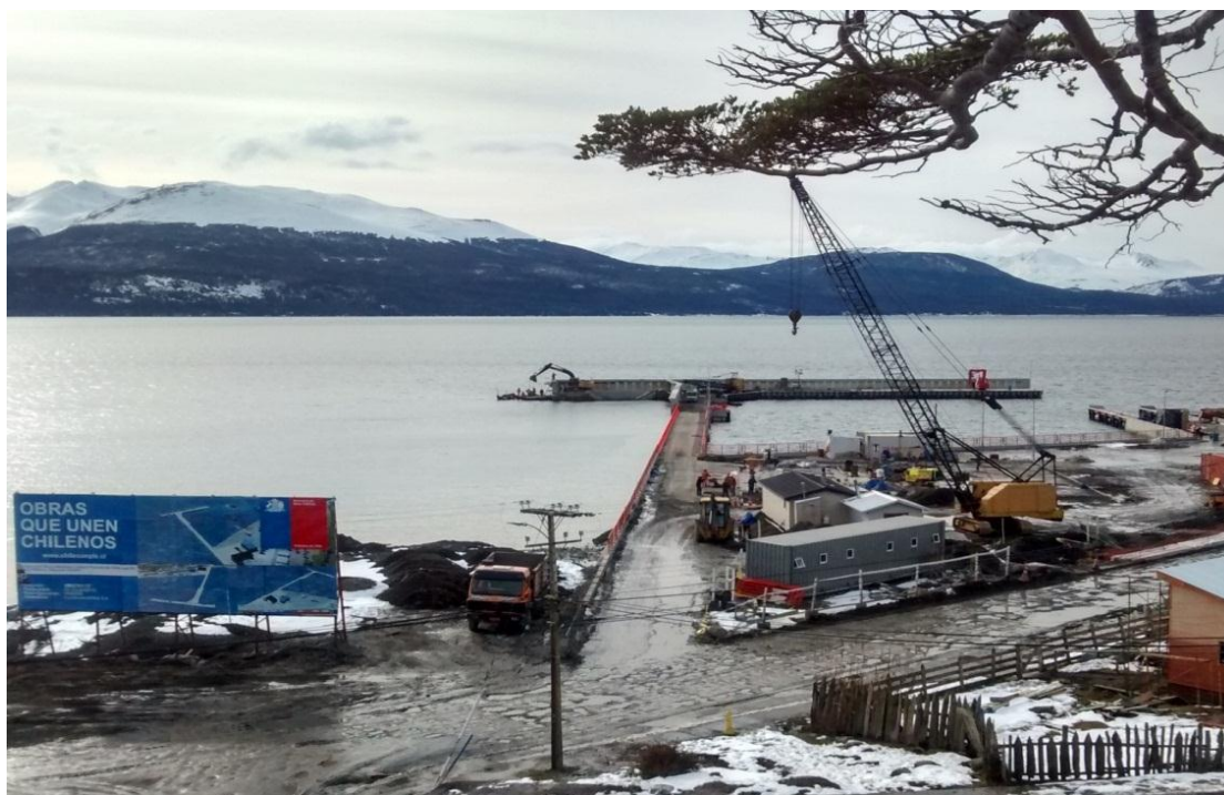
Obras marítimas Caleta de pescadores artesanales en Puerto Williams.
