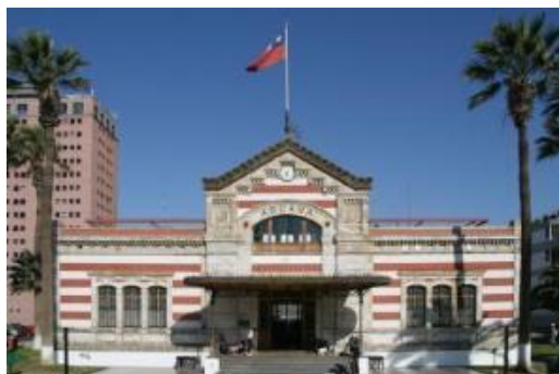
Edificio Ex Aduana de Arica.
