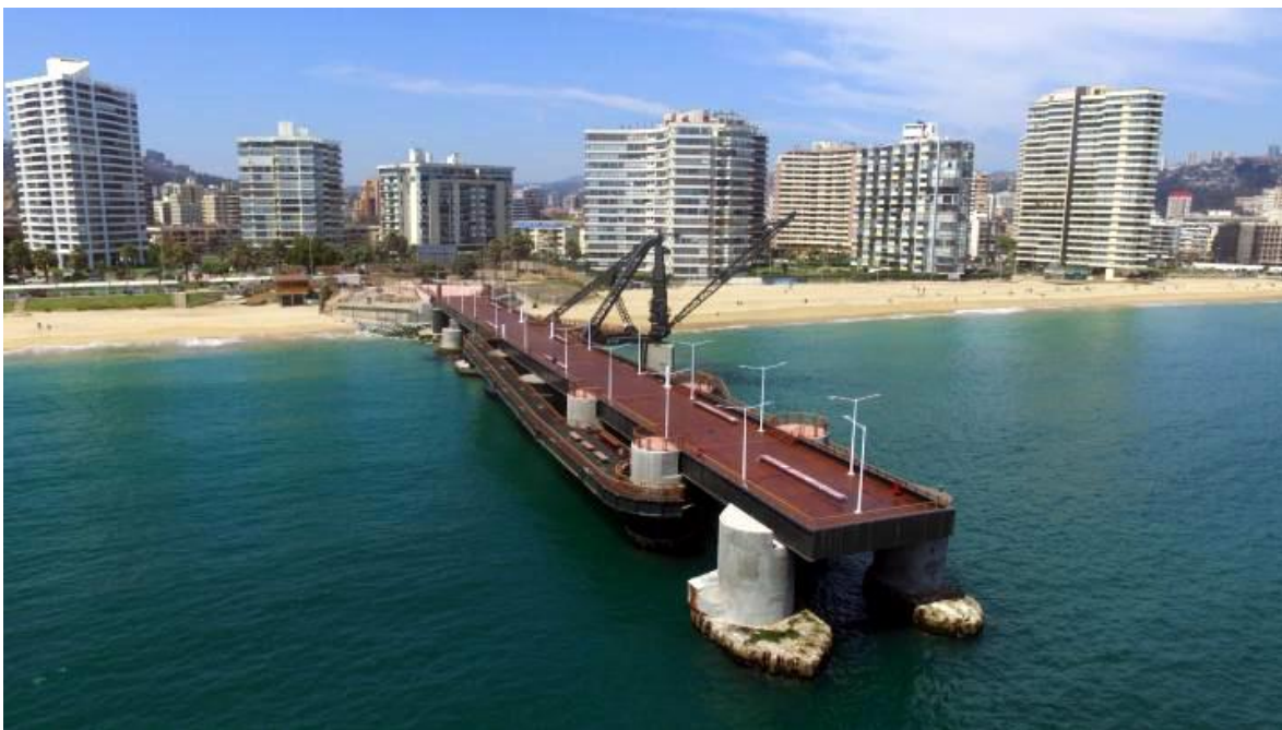
Restauración Muelle Vergara, Viña del Mar.
