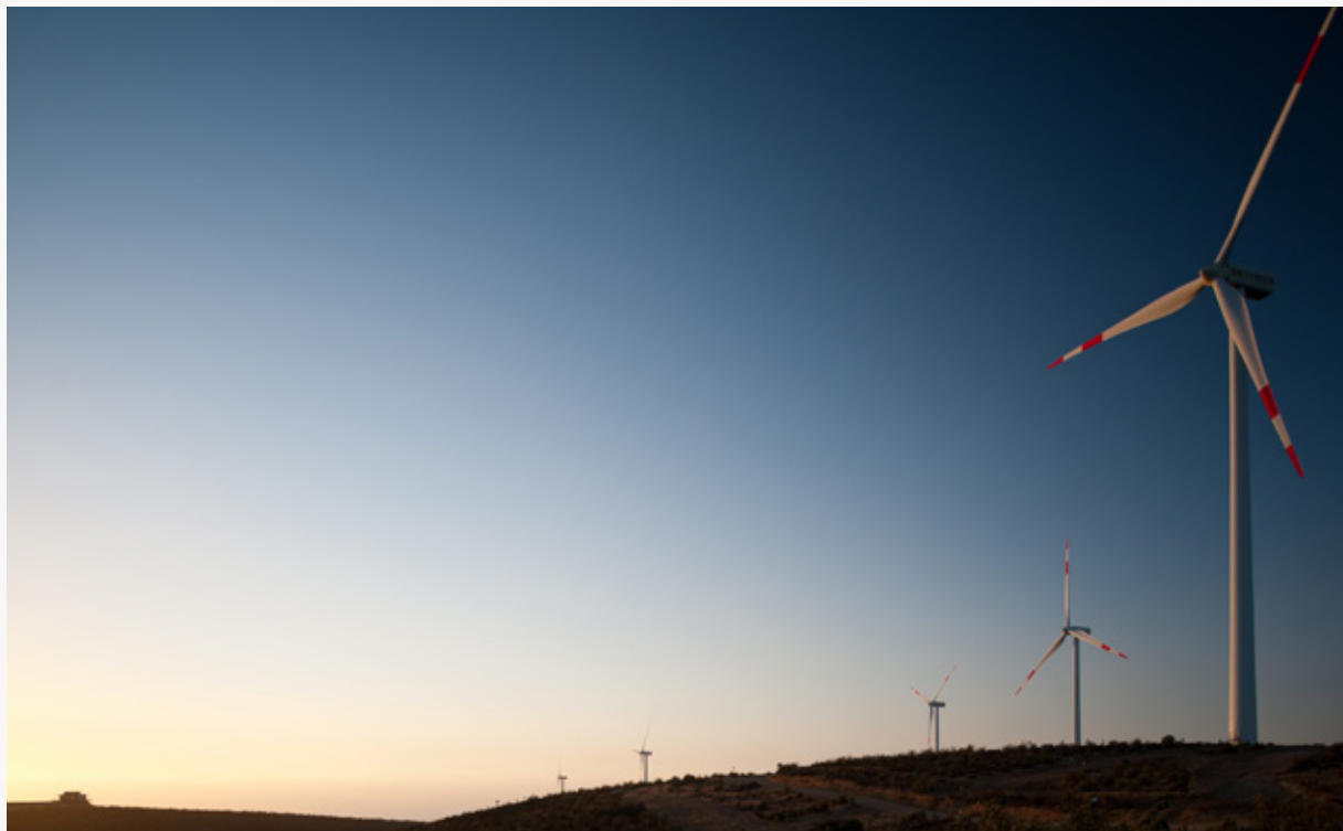
Fotografía: Felipe Cantillana / Imagen de Chile / Parque Eólico - Sn Power , Choapa
