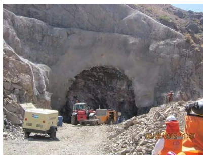
Túnel de salida embalse Chacrillas
