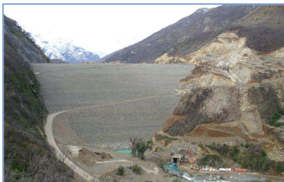
Vista de: Presa, Camino por Talud aguas abajo, Vertedero y Salida Túnel
