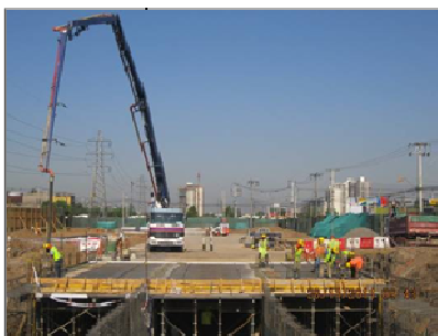
Obras de Construcción Parque inundable La Aguada
