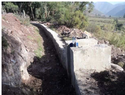
Mejoramiento Canales Cuz-Cuz, Bellavista Alto y Turbina
