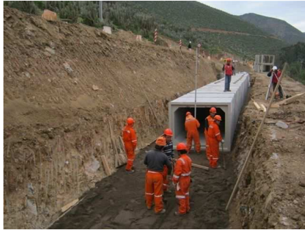
Construcción Canal Nueva Cocinera
