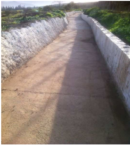
Mejoramiento Canales Cuz-Cuz, Bellavista Alto y Turbina
