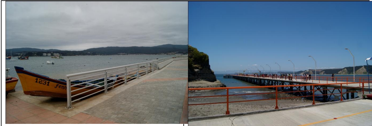
Obras Borde Costero Coliumo, y Tubul, VIII Región.
